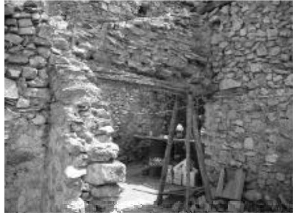
Zona de la barra de una "peña". La supresión de uno solo de los puntales hubiera provocado el hundimiento de la zona de fábrica de piedra que apoya sobre el cargadero
