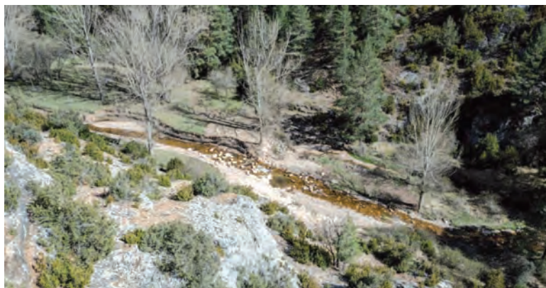
Uno de los tramos restaurados en el río Cabrillas, con algunas piedras del azud demolido.
