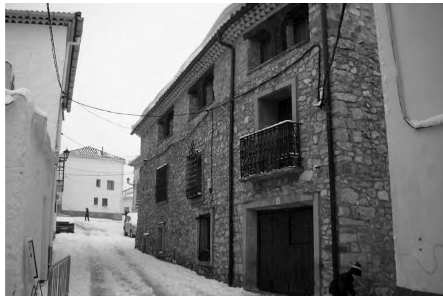
Fachada de Casa de Miguel Martínez y Pilar
